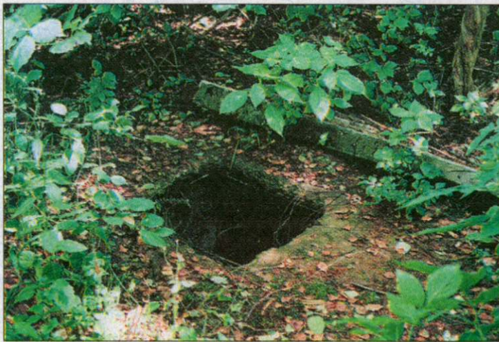
Betonową pokrywę zastaliśmy odsuniętą...
